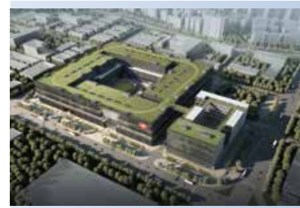
Zahájení výstavby Han's Laser Global Manufacturing hub
